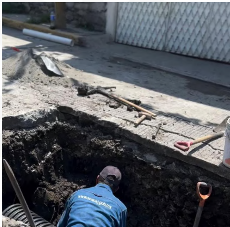
Reparación de drenaje fracturado por socavones en la colonia el Porvenir.
