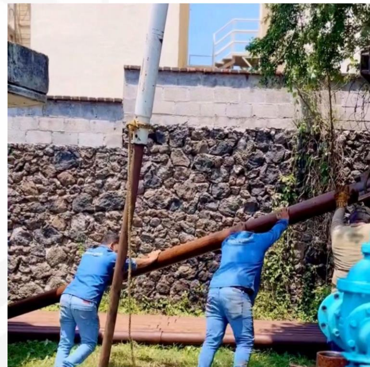
Reparación de equipo de bombeo en el pozo de agua de la Unidad Habitacional El Pochotal.
